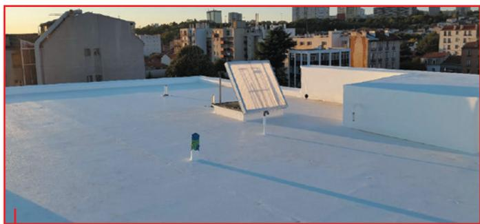
Étanchéité par membrane ALKORBRIGHT
