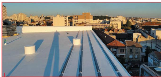
Étanchéité par membrane ALKORBRIGHT et profilés PVC-P soudés
